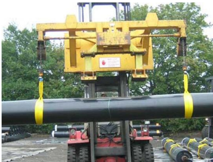
شکل ۳: نمایی از رولهای ژئوممبرین در حال حمل با قلاب های کمربندی
