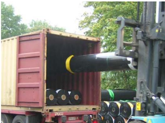
شکل ۲: تصویری از بیرون کشیدن رولها توسط لیفت تراک با لوله فولادی
